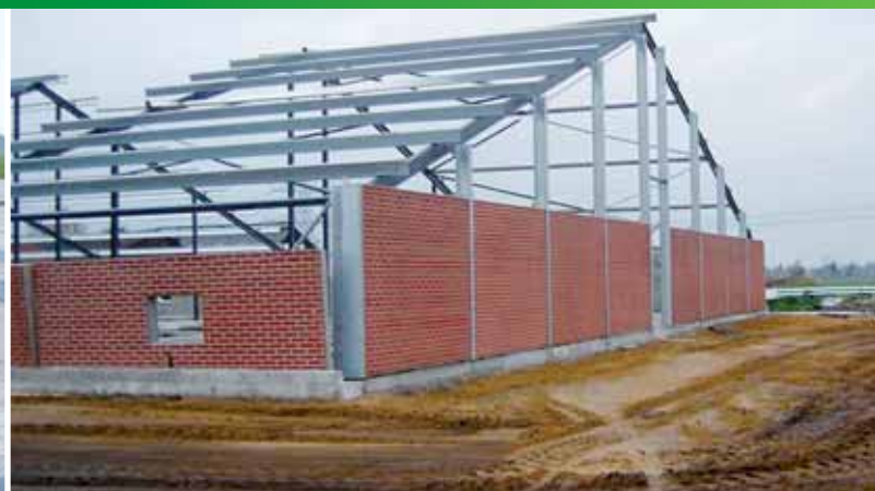
Durch Stahlpfetten ist eine größere Rahmenabstand möglich. Die Fertigelemente haben einen sehr hohen Isolierwert und ermöglichen eine besonders schnelle Bauweise.
